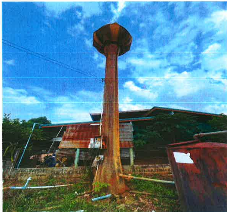
หอถังประปาหมู่บ้านคุ้มโรงเรียน
