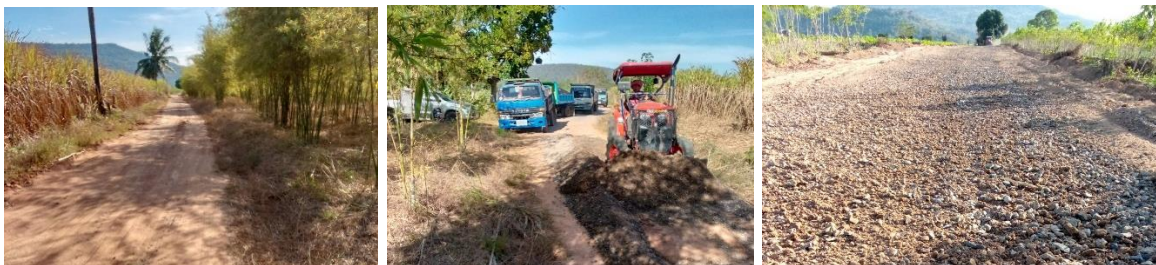
ปรับปรุงถนนหินคลุก หมู่ที่ ๒ บ้านห้วยสะพาน สายบ้านห้วยสะพาน-บ้านคลองไทร งบประมาณ
