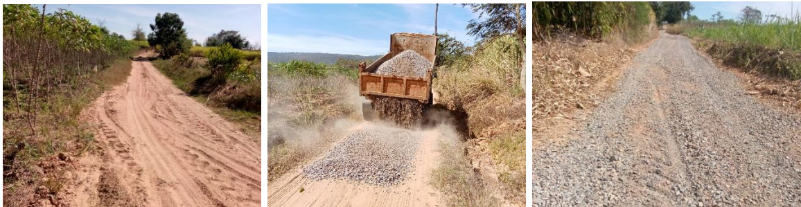
ปรับปรุงถนนหินคลุก หมู่ที่ ๖ บ้านโคกสะอาด สายขึ้นสี่-เขาเหล็ก งบประมาณ ๙๗,๐๐๐.๐๐ บาท
