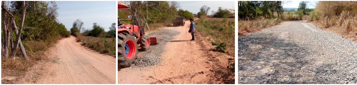
ปรับปรุงถนนหินคลุก หมู่ที่ ๓ บ้านวังตาทำว สายบ้านวังตาทำว-บ้านวังช้าง งบประมาณ ๙๗,๐๐๐.๐๐ บาท
