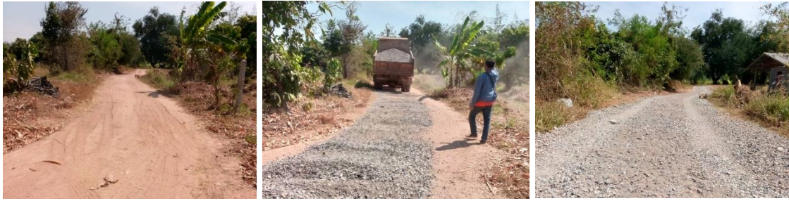
ปรับปรุงถนนหินคลุก หมู่ที่ ๓ บ้านวังตาท้าว สายห้วยล้างชาม งบประมาณ ๙๙,๐๐๐.๐๐ บาท
