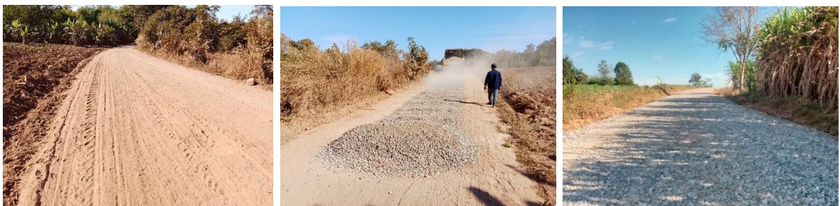
ปรับปรุงถนนหินคลุก หมู่ที่ ๑๕ บ้านประตู่ชัยภาค สายบ้านแก่งงบประมาณ ๙๗,๐๐๐.๐๐ บาท
