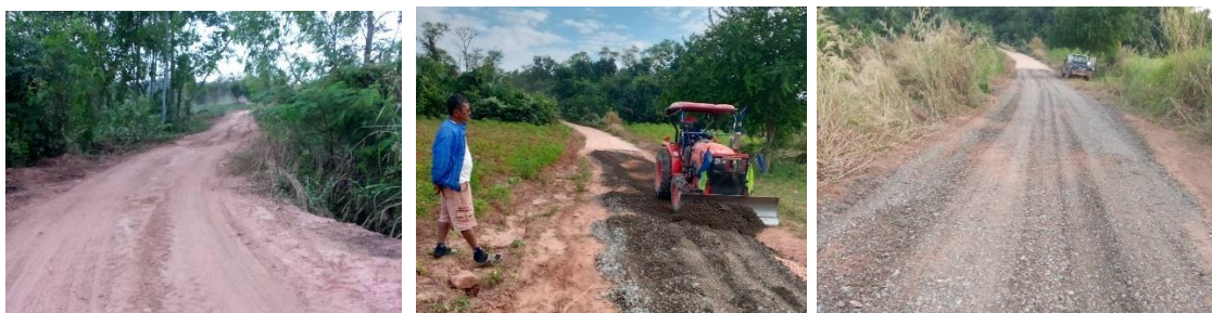
ปรับปรุงถนนหินคลุก หมู่ที่ ๑๐ บ้านห้วยหินฝน สายอ่างเพิ่ม งบประมาณ ๙๙,๐๐๐.๐๐ บาท
