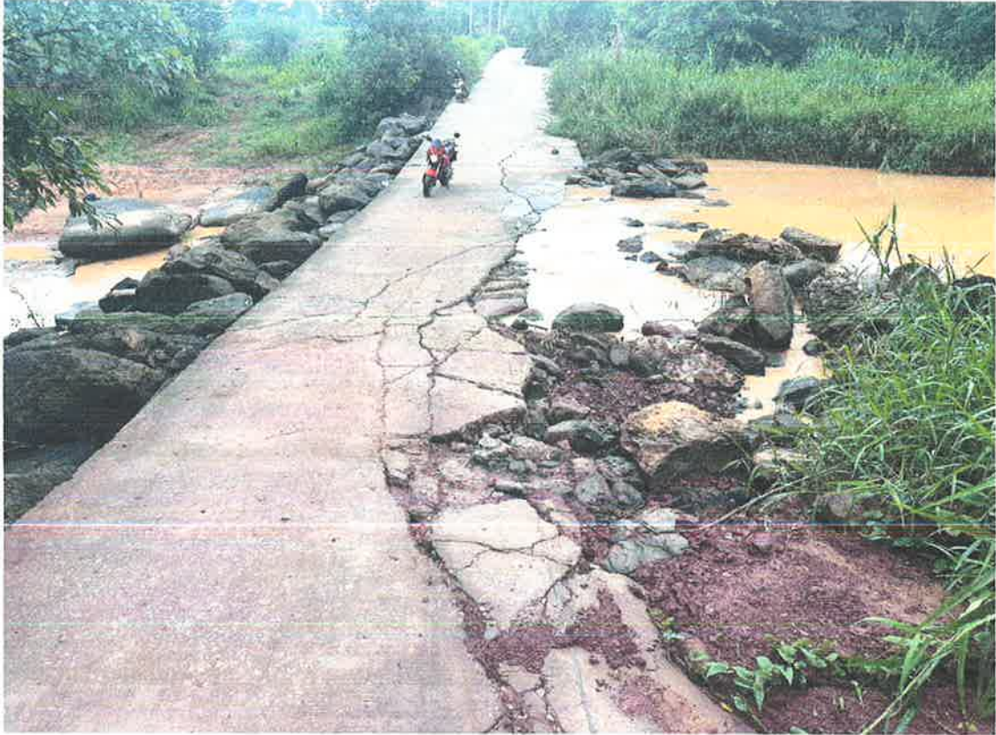
ถนนคอนกรีตเสริมเหล็กบริเวณทางข้ามลำกระจวนบ้านโนนจำปา หมู่ ๑๓ ตำบลนายางกลัก อำเภอเทพสถิต จังหวัดชัยภูมิ
